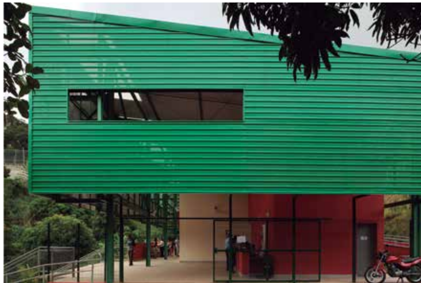
El centro comunitario se concibió como una gran plaza cubierta. Foto: Leonardo Finotti.
