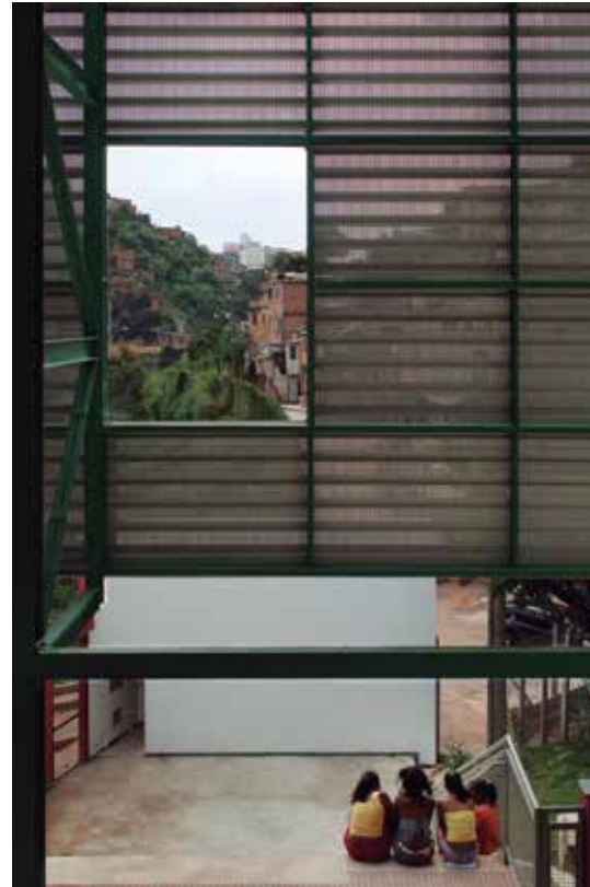
Desde el interior, la chapa perforada ofrece un efecto semitransparente. Foto: Leonardo Finotti.
