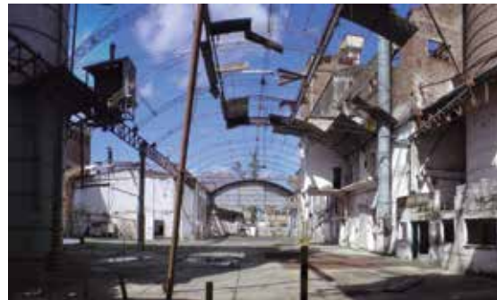
Estado del lugar en 2008, antes de la intervención. El molino es de 1894 y estuvo integrado al sistema ferroviario. Foto: Unidad de Proyectos, Ministerio de Obras Públicas.
