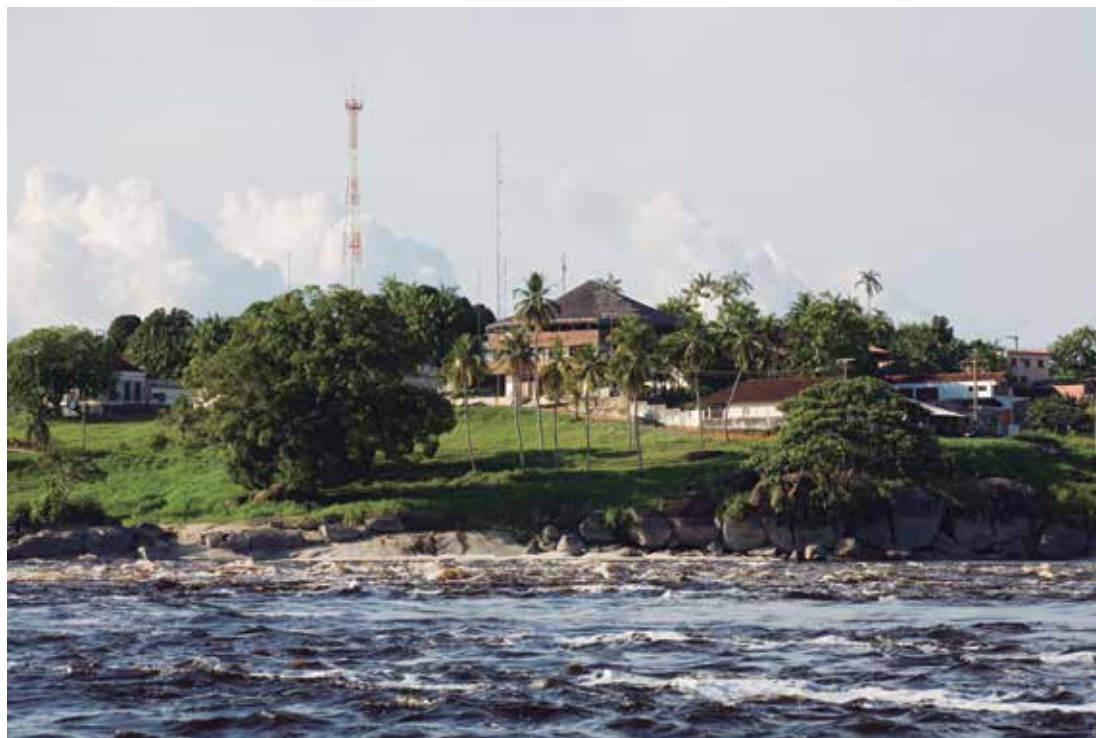
Vista de la edificación y su entorno desde el río Negro. Foto: Daniel Ducci.
