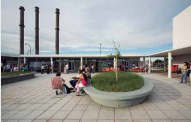
Centro Municipal del Distrito Sudoeste, Rosario, Argentina, 2008. Pelli Clarke, Pelli Architects – Balmori Associates, FMR Faure, Malamud, Riveira Arquitectos. Foto: Gustavo Frittegotto.
