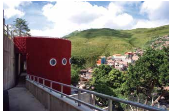
Se accede a la edificación desde la parte superior. Foto: Pedro Meyer.
