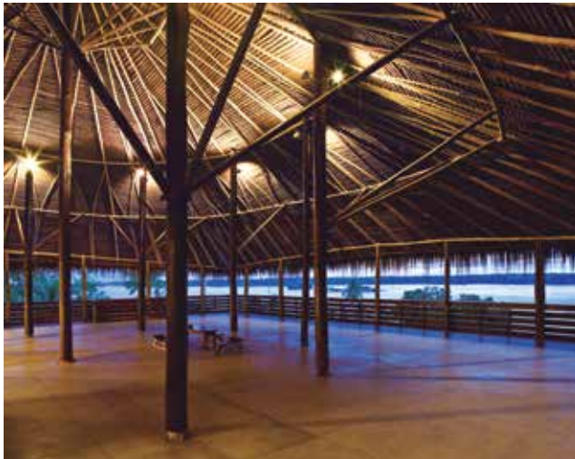
Estructura de la cubierta en el último piso, el techo es en madera, bejucos y paja piasava. Foto: Daniel Ducci.
