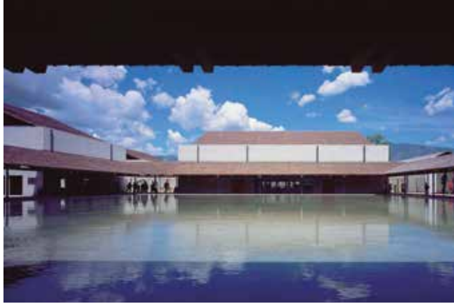
Plaza del agua bordeada por un recorrido cubierto. Foto: Parque Biblioteca Belén.
