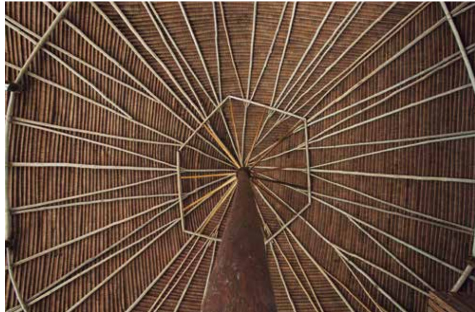
Estructura de la cubierta. Foto: Daniel Ducci.
