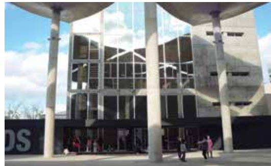
Fachada principal del edificio de talleres. Foto: Unidad de Proyectos, Ministerio de Obras Públicas.
