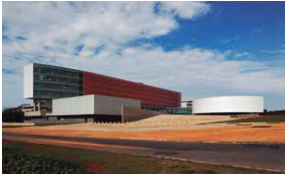
Vista del conjunto desde la esquina que cruza con el eje monumental. Foto: Nelson Kon.
