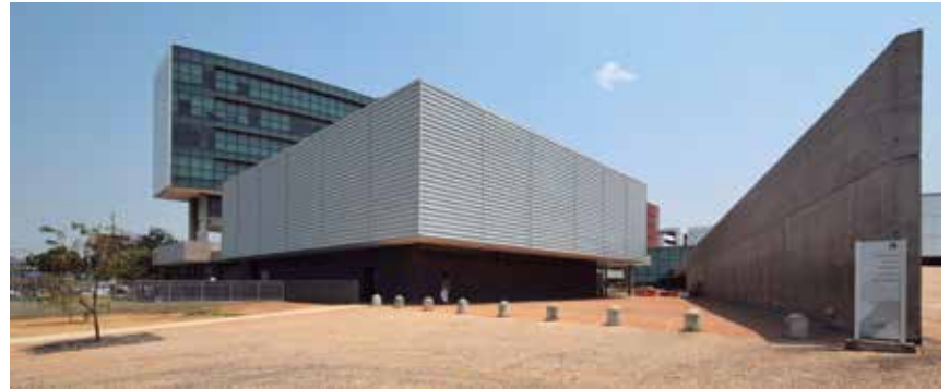
Acceso a la plazoleta interna entre el volumen del auditorio y el muro diagonal. Foto: Sidney Vieira de Carvalho
